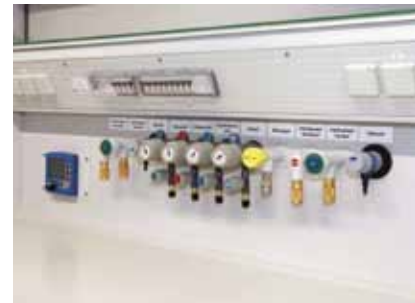
Instalación del controlador dentro del panel de medios de conexión
